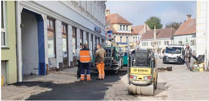
**Hauptplatz** – Nach Abschluss der Sanierungsarbeiten von Teilen des Schmutz- und Regenwasserkanals bzw. auch der Fernwärmeleitungen wurde ein provisorischer Asphaltbelag zur Überwinterung im Hauptplatzbereich hergestellt. Die endgültige Gestaltung des Hauptplatzes sowie der angrenzenden Straßenzüge erfolgt im kommenden Jahr.
