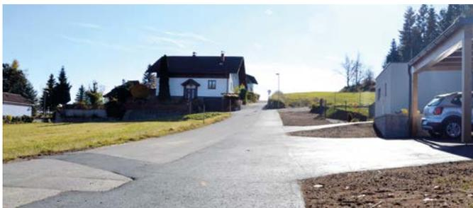
**Pappelweg** – Am Pappelweg wurden Anschlussasphaltierungsarbeiten und die Befestigung der Straßenverbreiterung durchgeführt sowie Einlaufgitter zur besseren Ableitung der Oberflächenwässer versetzt.
