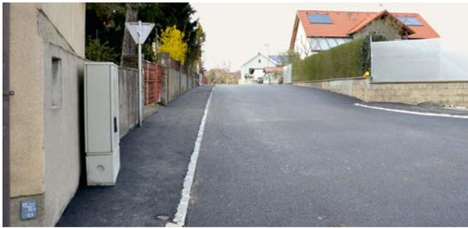
In der Seitengasse wurde der Unterbau erneuert und eine neue Asphalt-schicht aufgetragen. Die Bauarbeiten sind somit abgeschlossen, die Gesamtausgaben belaufen sich auf rund € 100.000,-.
