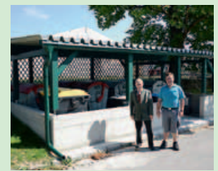
Bgm. Ök.-Rat Karl Simlinger und Schulwart Manfred Gföhler vor der neu errichteten Müllinsel beim Hauptschulgebäude.
